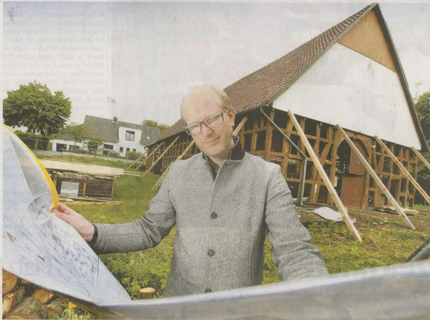
Alles im Plan: Architekt Henning Bökamp wirft einen Blick in den Bauplan. Im Moment laufen die Sanierungsarbeiten des Fachwerks. Noch sichtbar Holz balken das marode Gebälk ab.
