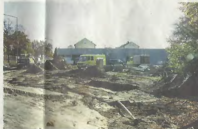
Im Bau: Ein weiteres Gebäude mit etwa 400 Quadratmetern Fläche entsteht noch auf dem Gelände am Südring.
