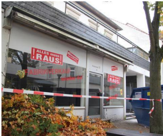
Ist bald Geschichte: Das Haus Klosterstraße 19 weicht einem Neubau.
