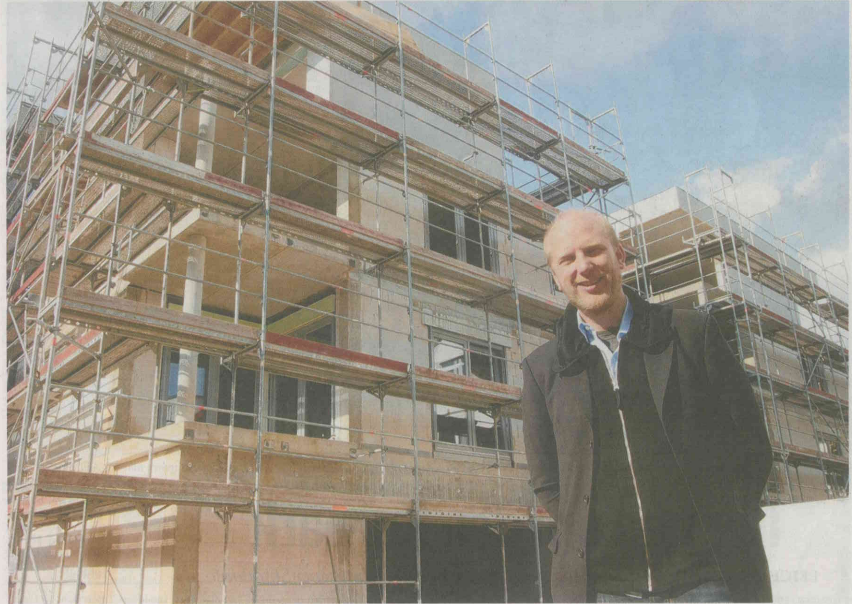
Das Werkwächst: Architekt Henning Bökamp vor der Südfassade des Neubaus in der oberen Klosterstraße. Der Rohbau steht, zurzeit werden die Fenster-Elemente montiert.
