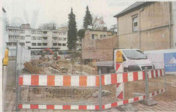
Noch recht leer: Viel ist auf der Abrissfläche nicht sichtbar. Doch im Sommer 2010 soll das neue Haus stehen.
