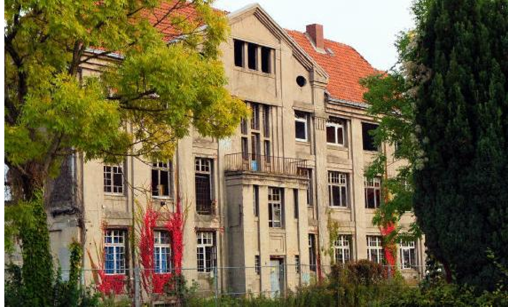
Ruine mit Charme: Die alte Schokoladenfabrik am Alten Rehmer Weg hat das Potenzial, ein Schmuckstück für Rehme zu werden. Davon ist Architekt Henning Bökamp fest überzeugt. Er will das 1910 gebaute Objekt im nächsten Jahr sanieren. FOTO: THORSTEN GÖDECKER
